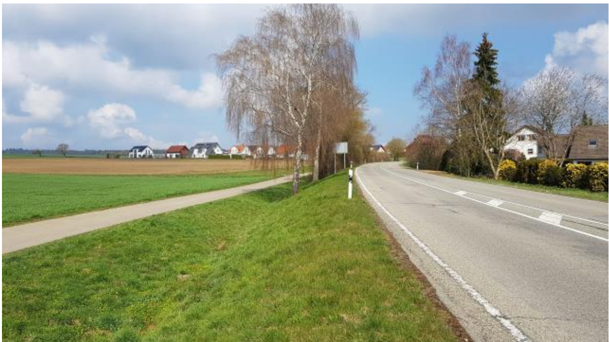
Geh- und Radweg, Böschungsbereich und L273 auf der Ostseite des Geltungsbereiches
